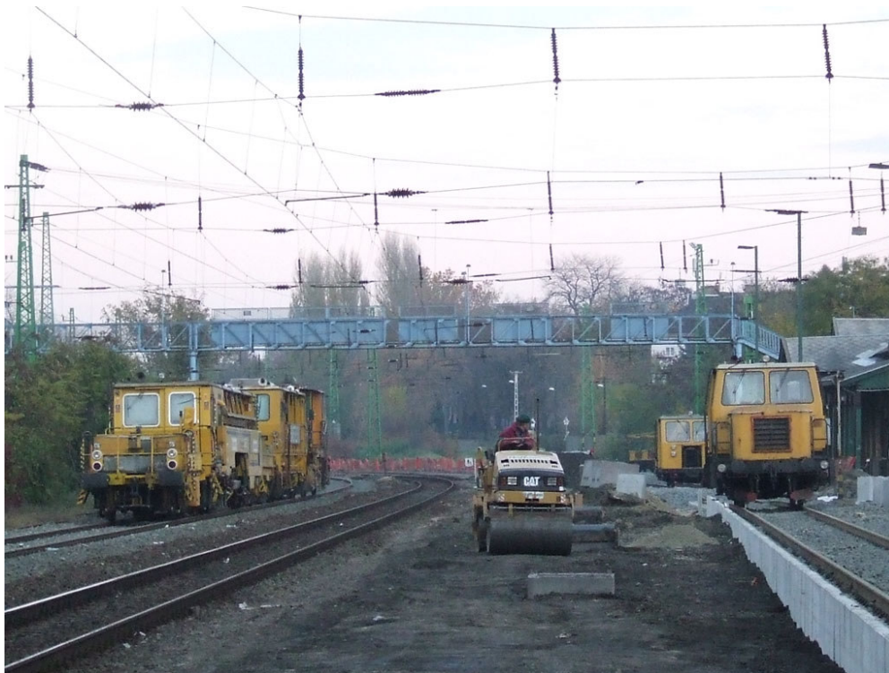
7. ábra: irányítás és figyelőőr nélkül, hátramenetben közlekedő munkagép: 20 másodperccel később vonat haladt el mellette
