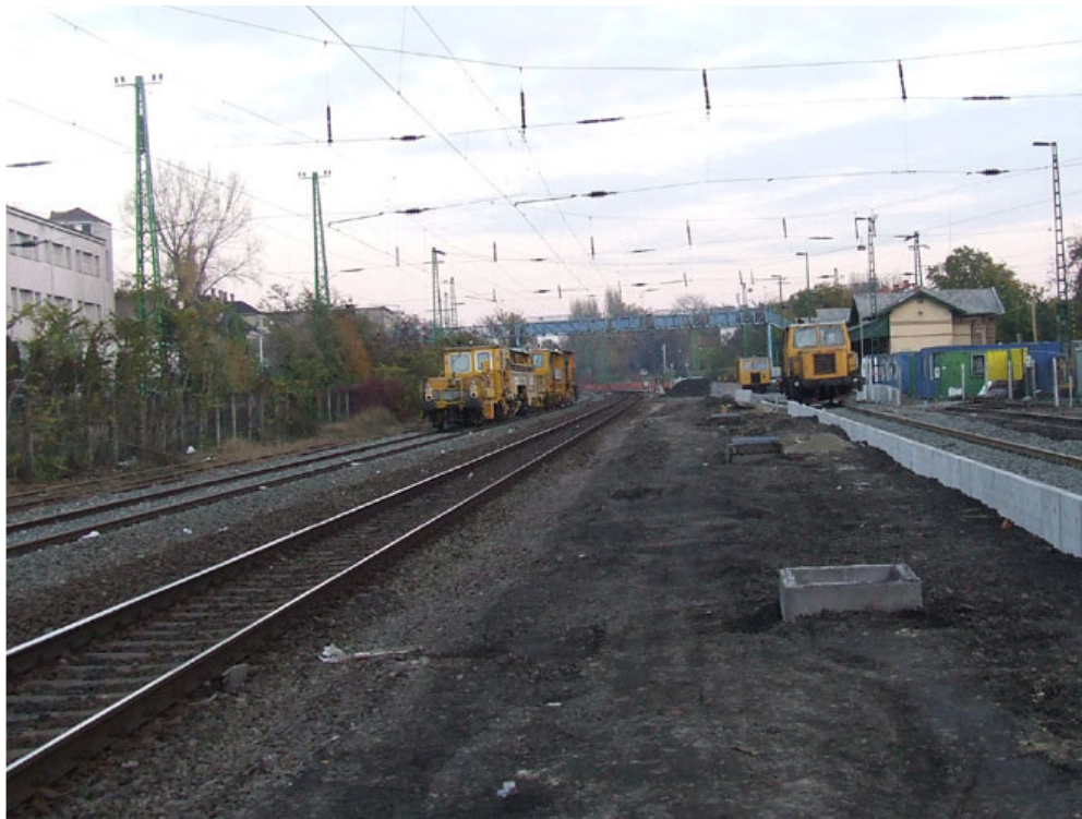
5. ábra: a csatornaszem csak az úrszelvény igénybevételével kerülhető ki
