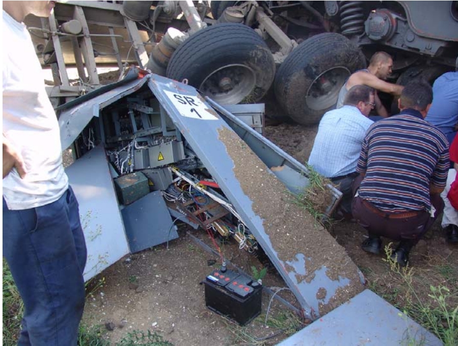
4. ábra A megrongálódott sorompószekrény
