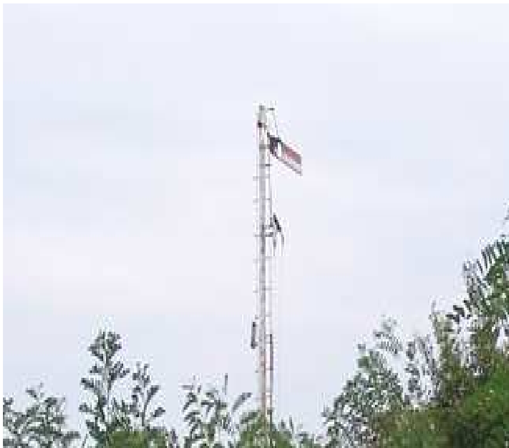
3. ábra: Bodakajtor-Felsőszentiván mrh "A" jelű használhatatlan fedező jelzője
