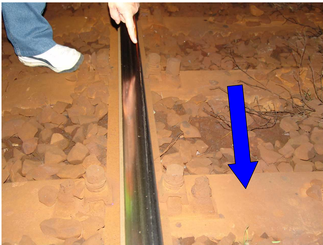
8. ábra: A siklás első nyoma a jobb vágány jobb sínszálán (254+25 sz. szelvény)
