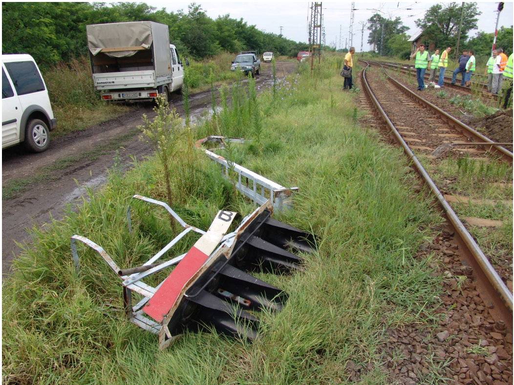
5. ábra: A kidöntött és megrongálódott fényjelző
