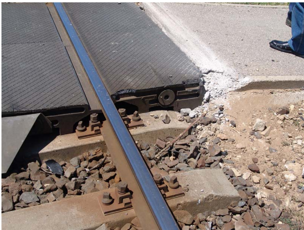
5. ábra: Kismértékben elmozdult STRAIL elem a gyalogos átjárónál
