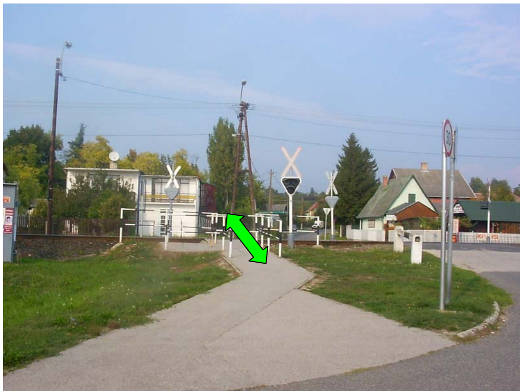
13. ábra: A sorompó fényjelzőkkel ellátott gyalogos átjáró
