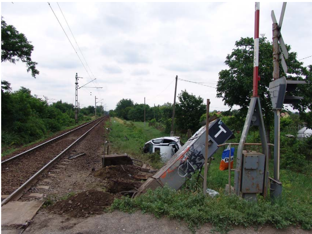
6. ábra: A kifordult sorompószekrény
