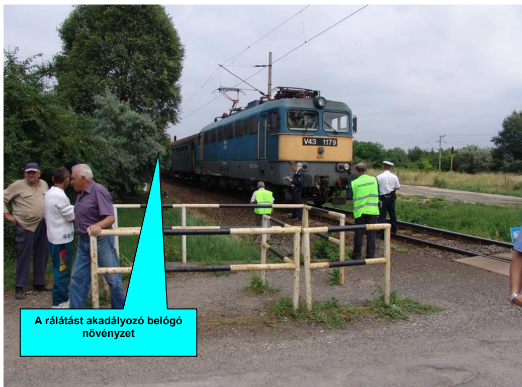
7. ábra: A közút tengelyében a sorompó fényjelző oszlopától visszafelé mért 1 m távolságból rálátás a vasúti pályára Érd-elágazás felé
