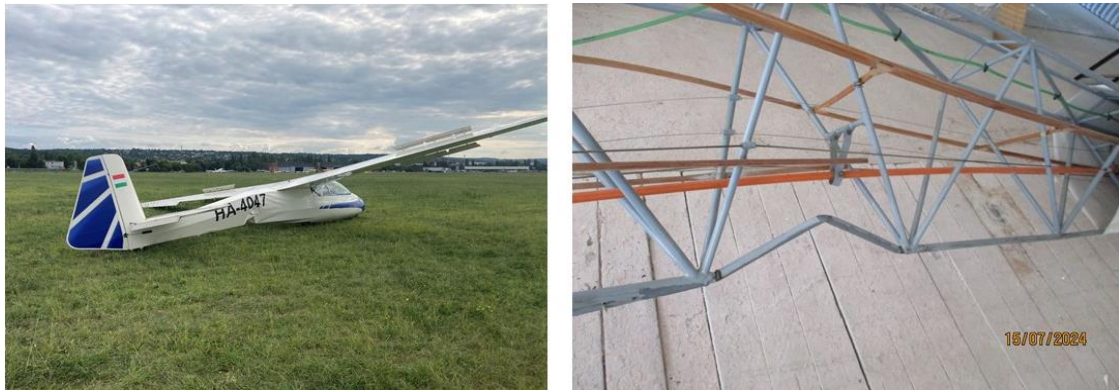
3. ábra: A törzs rácsszerkezetének sérülése
