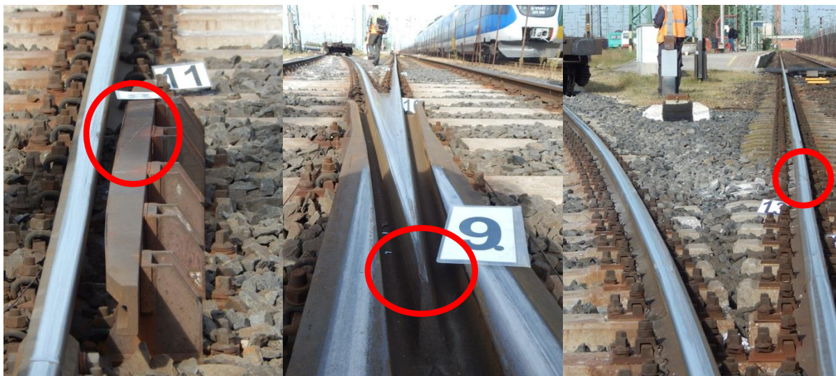
7. ábra: a kerék által átlépett vezetősín (38/b sz. váltó)
