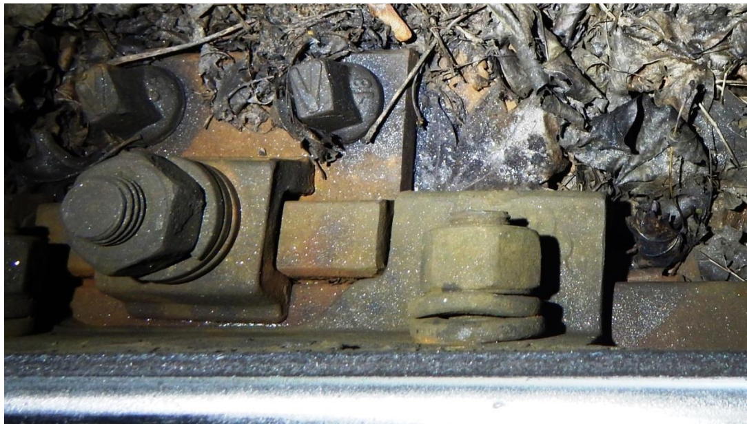
7. ábra: az eset helyén lévő kis sugarú ívben is jól megfigyelhető a finom szemcséjű, ezüstös színű fémreszelék az ív külső oldalán, a sínillesztés körüli kapcsolószeréken
