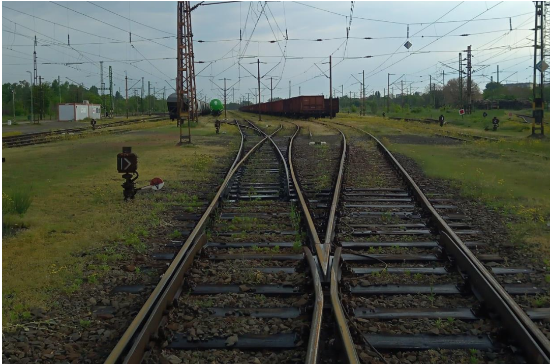
6. ábra: az esetben fontos, F24 vágányra terelő 154 sz. váltó a kép az esetet követően néhány nappal készült, az ütközés helyét adó F22 vágányon a zöld tartálykocsik állnak
