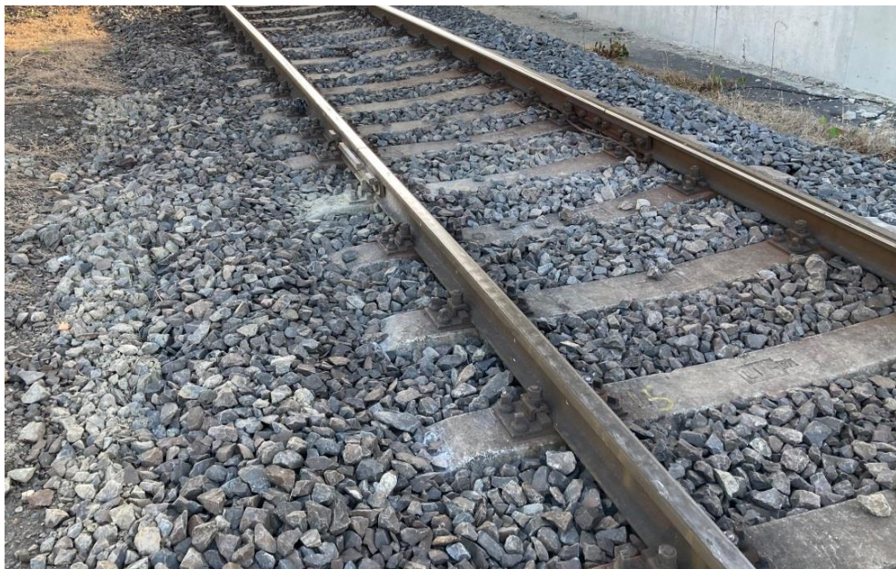
6. ábra: alépítményhibára utaló nyomok a baleset helyének környezetében
