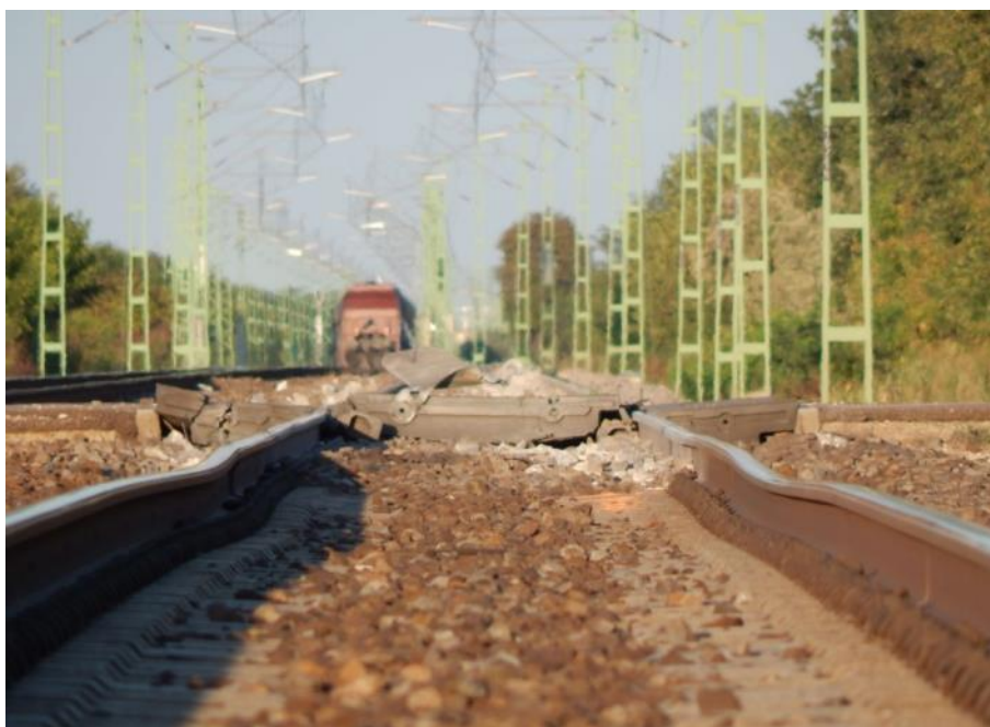
5. ábra: a kisiklás helyét megelőző vágánygeometriai hiba
