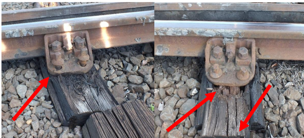
3. ábra: a sínszék keresztirányú mozgásának nyomai, a kiszakadt síncsavarok és a pántoló szalag hiánya
