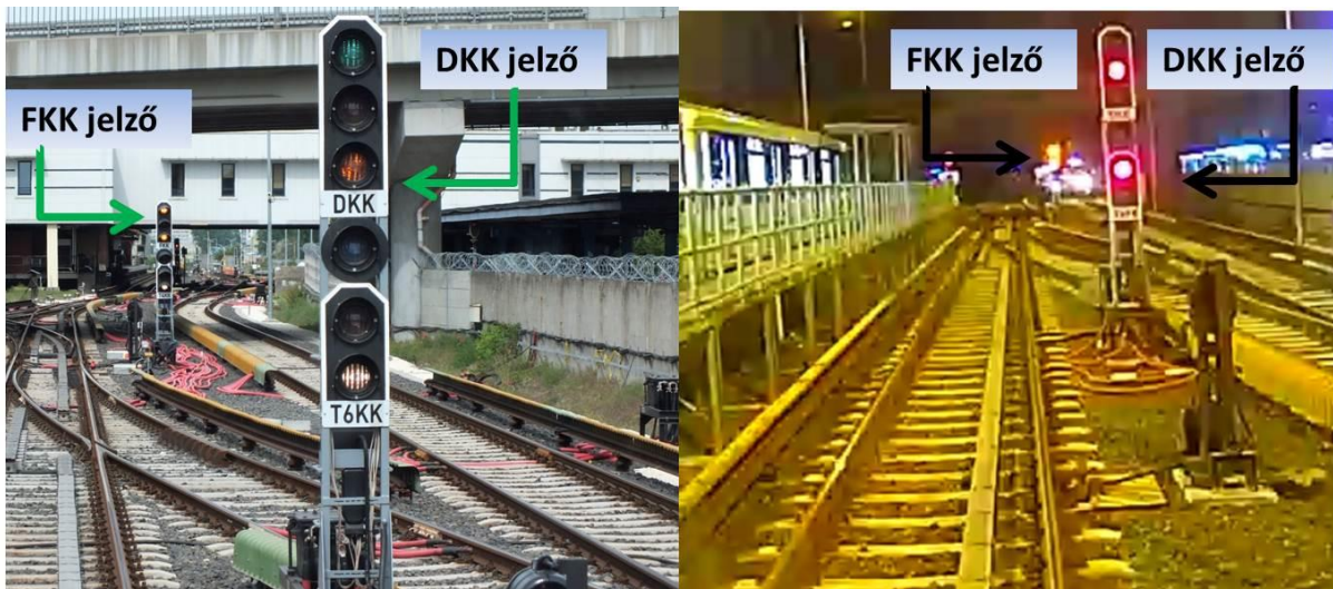
12. ábra: DKK és FKK jelzők a „Kihúzó II.” vágányról beállított vágányút esetén (bal), és a baleset előtt a pályakamera által rögzített esetben (jobb)
