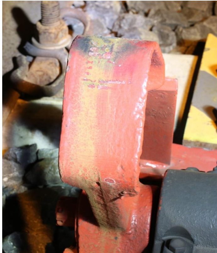
11. ábra: Friss ütésnyomok az Autostop pályaoldali elemének felületén
