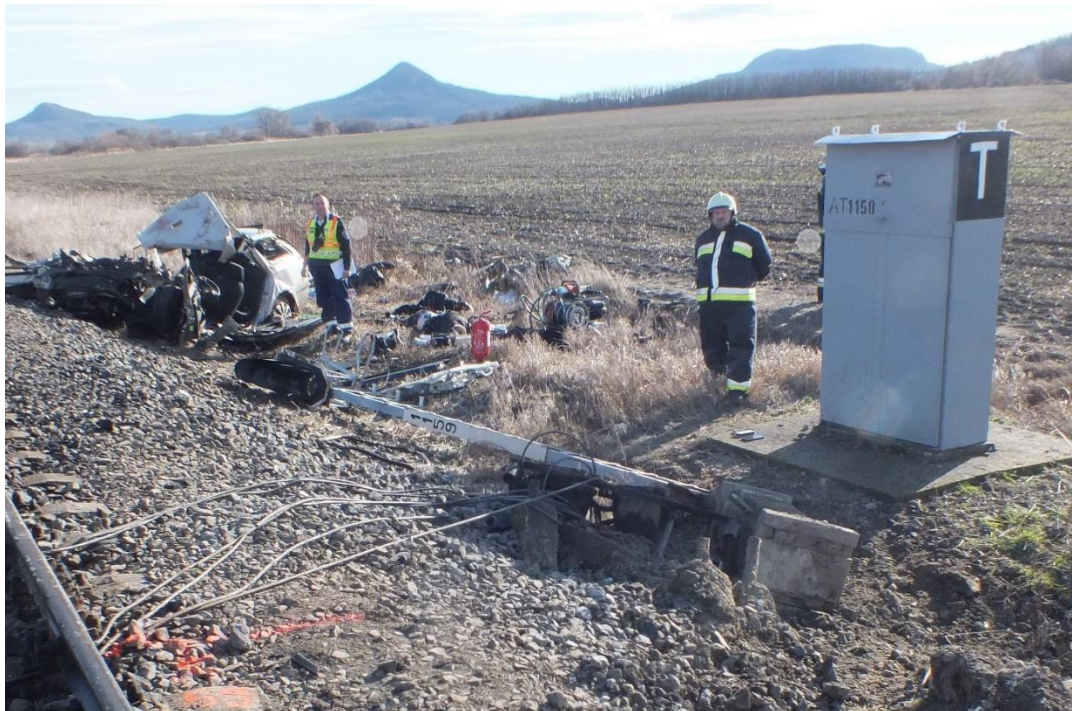
6. ábra: A kidöntött térközjelző
