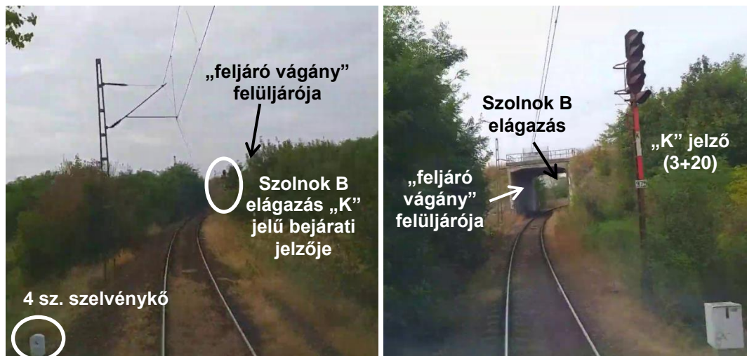
4. ábra: rálátás a vasúti pályára (nappal) a ceglédi „kijáró vágányon” B elágazás felé haladva a megállás körülbelüli helyéről, azaz a 4 sz. szelvényben (balra) és a bejárati jelzőtől, azaz a 3+20 sz. szelvényben (jobbra) – illusztráció: az eset a valóságban éjszakai látási viszonyok között történt! [forrás: https://youtu.be/E9h_7GjftgY ]
