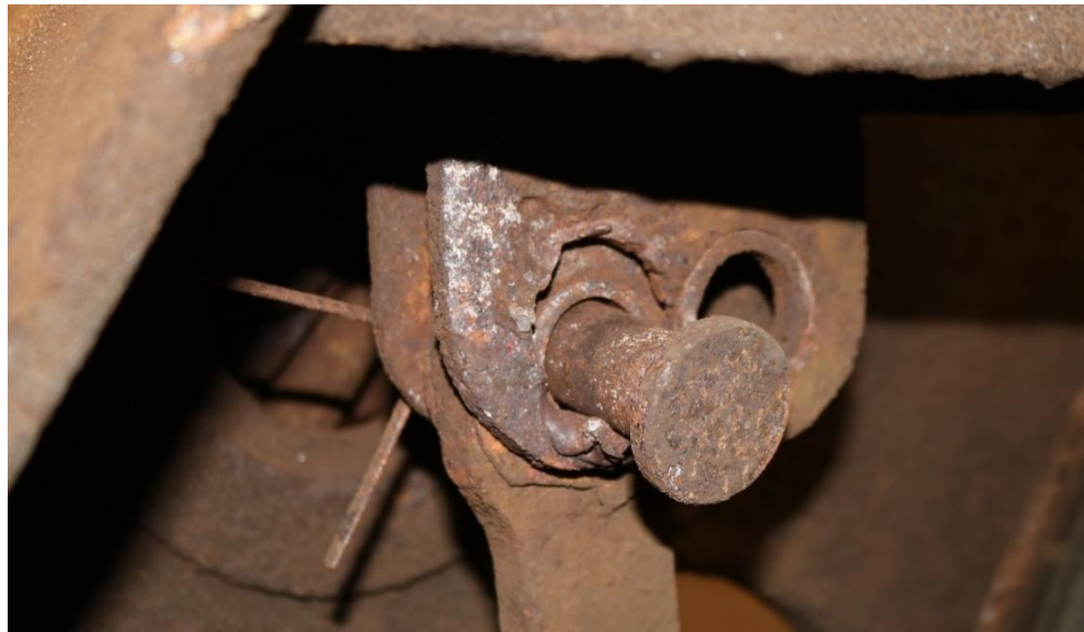
3. ábra: szakszerűtlen és korrodált fék függvas rögzítés
