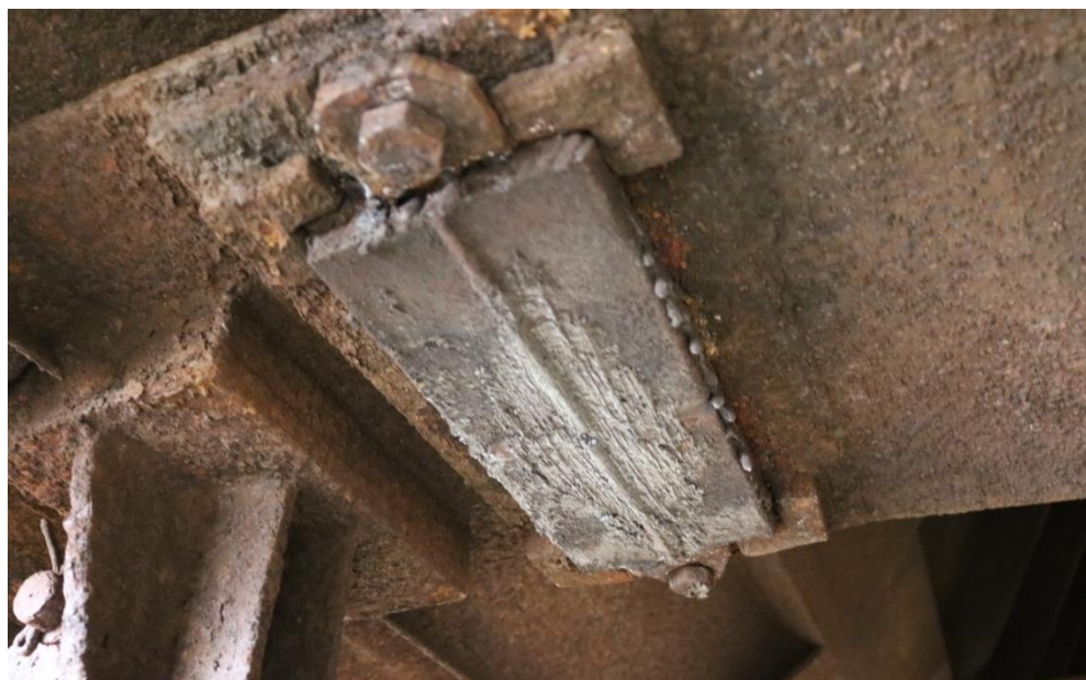
4. ábra: rugólap beépítve csúszótámként
