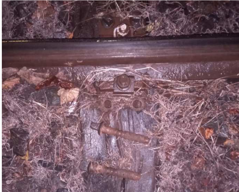
3. ábra: kiszakadt csavarok
