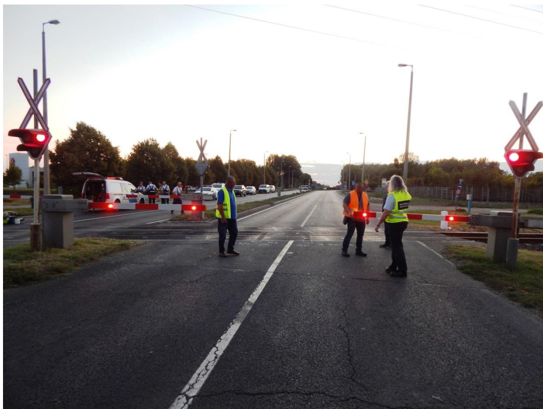
12. ábra: a félsorompók lezárt állapota (a csapórudak közti távolság kb. 3,3 méter)
