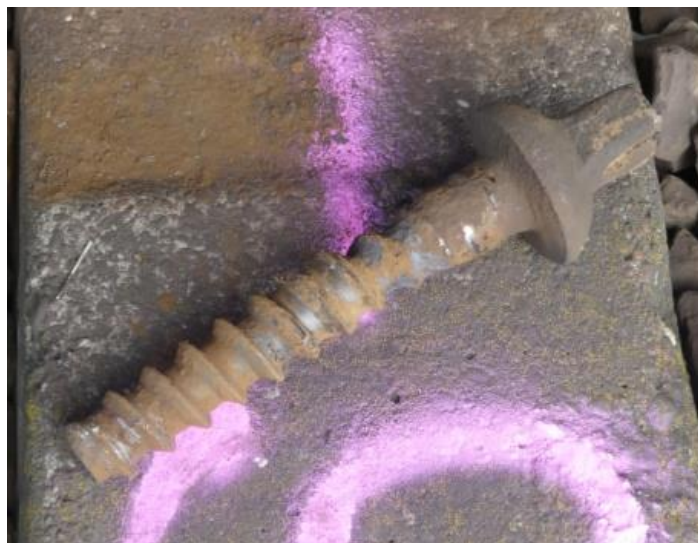
3. ábra: egy korrodált, elvékonyodott, de még el nem tört csavar
