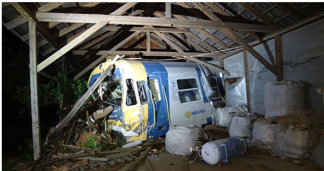
2. ábra: a raktárépületbe csapódott vezérlőkocsi
