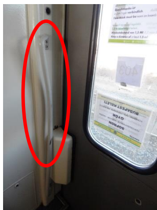
3. ábra: meggörbült kapaszkodó
