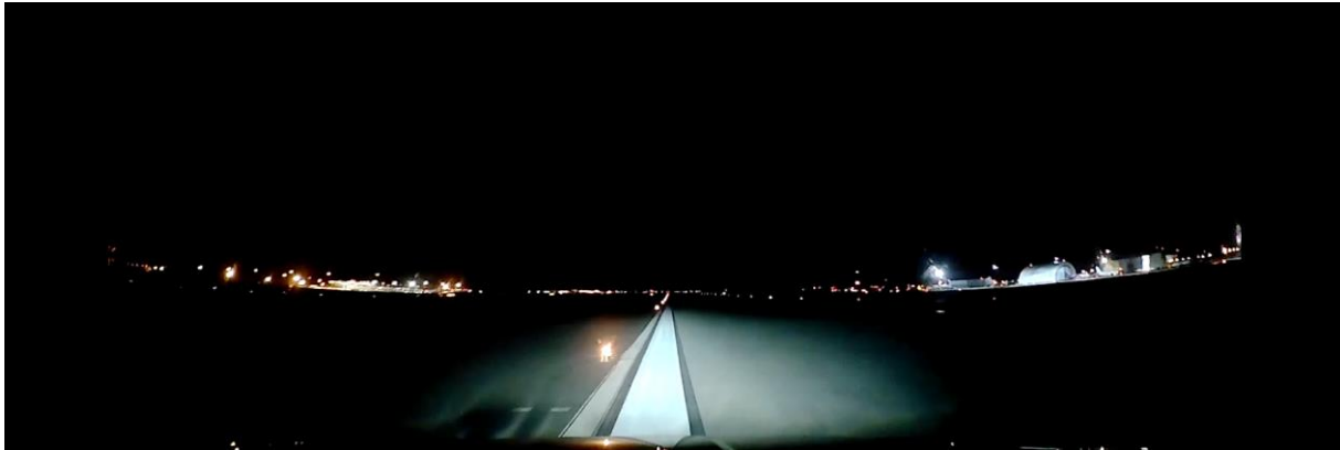
21. ábra - A pályaszegély és a pályatest burkolatának színekülönbsége éjszakai látási körülmények között a szegélyen gurulás során (forrás: KBSZ helyszíni rekonstrukció közúti gépjárművel)
