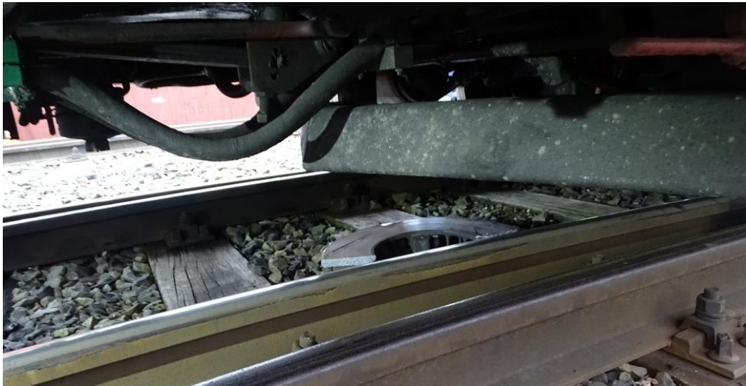
4. ábra: a letört féktárcsa darab a 6. sz. kitérő közbenső részén
