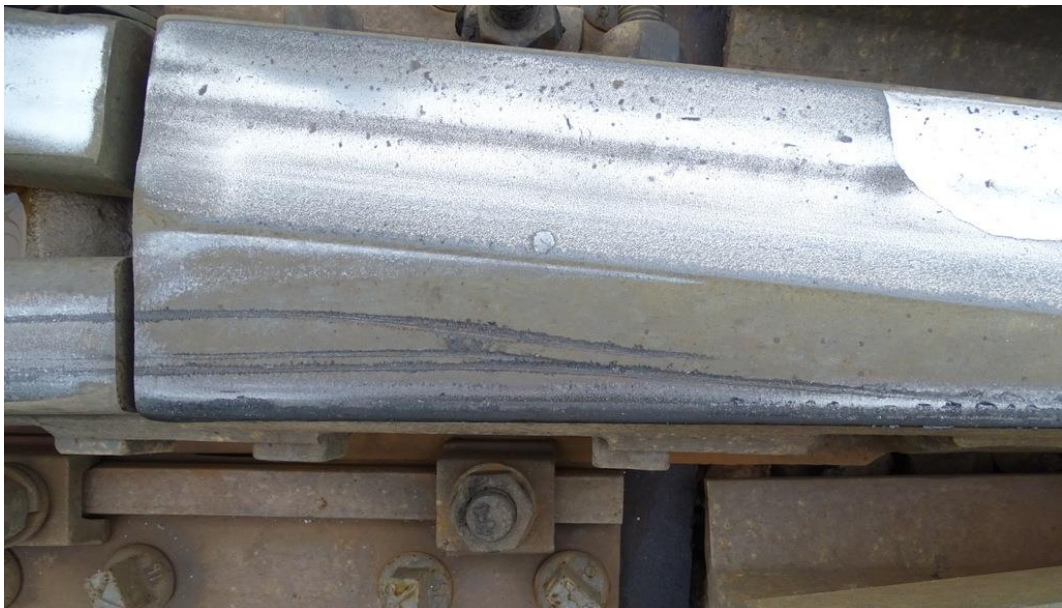
5. ábra: legalább három nyomkarima felfutási nyoma a 6. sz. kitérő keresztezési részén
