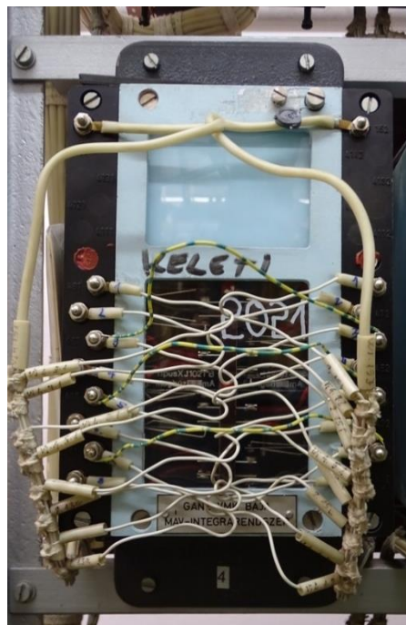
3. ábra: átkötések (sárga-zöld vezetékek) a IV. vágány jelfogóján
