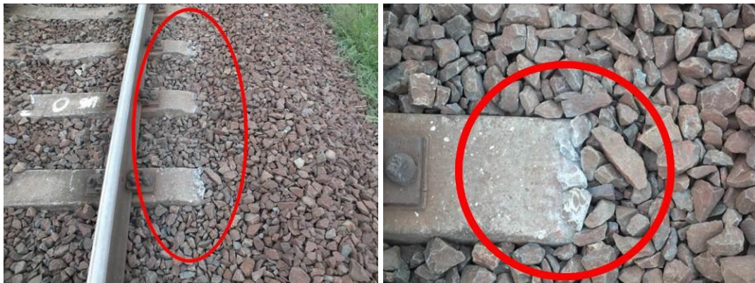
14. ábra: vaksüppedésre utaló nyomok
