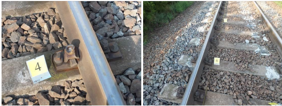
5. ábra: az elsőként siklott forgóváz okozta sérülések
