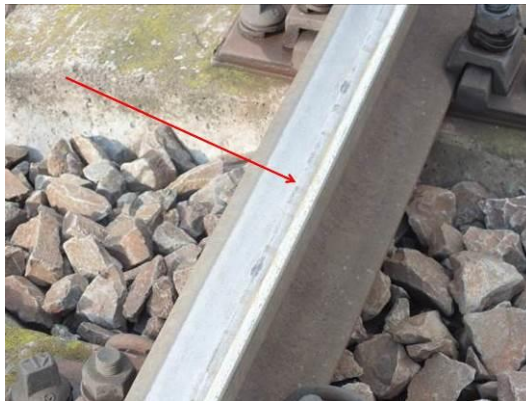
3. ábra: A nyomkarima nyoma a futófelületen
