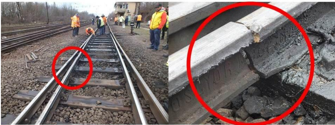
4. ábra: a törés a rugalmas csússínéknél használt csússzín gyengítésnél
