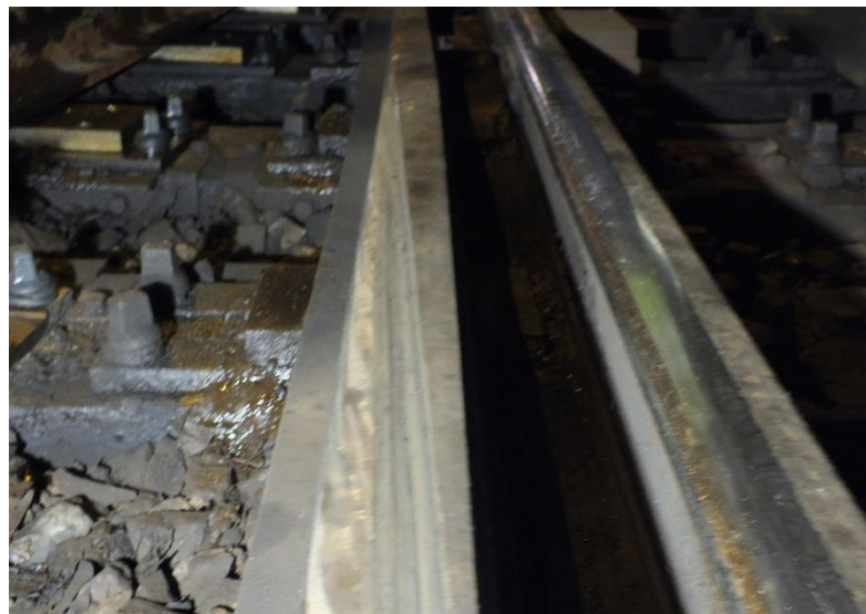
6. ábra második forgóváz felkapási nyoma
