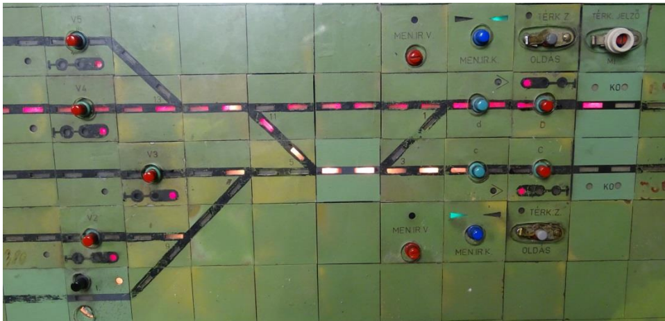
4. ábra A biztosítóberendezés kezelőpultja
