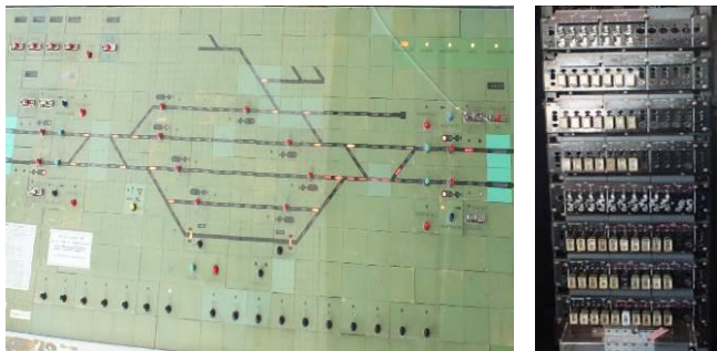
3. ábra: az állomás biztosító berendezésének a forgalmi irodába tartozó részei (kezelőpult és biztosíték szekrény)
