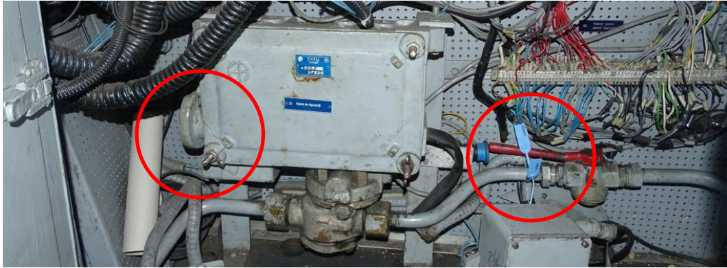
6. ábra: laza ólómzárdrót és eltolható műanyag zár
