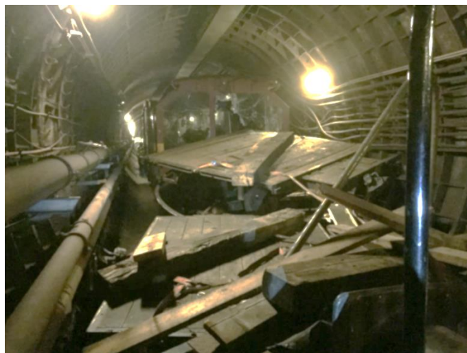
Roncok az alagútban (forrás: BKV Zrt.)
