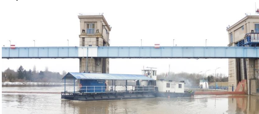
A duzzasztómű zsiliptáblájára sodródott kötelék
