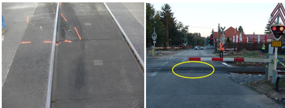
4. ábra: a nyomok és a leeresztett csapórúd egymáshoz viszonyított helyzete a sorompó próba alatt
