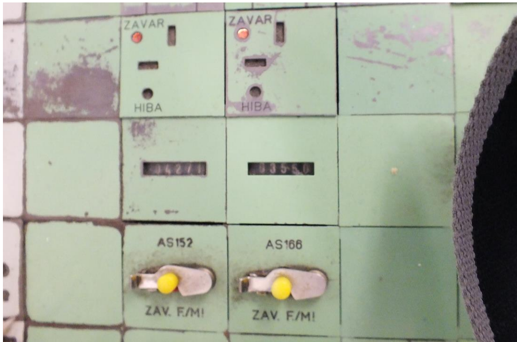
6. ábra: Az AS 152 sz. felsorompóval kiegészített fénysorompó visszajelzése Pécel állomás biztosítóberendezésének kezelőpultján
