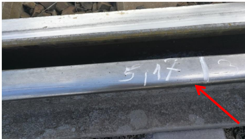
5. ábra: második forgóváz felkapási nyoma
