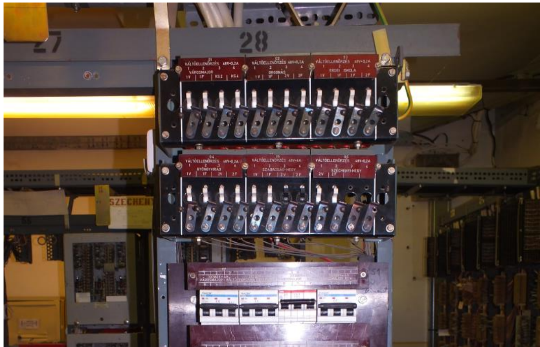
7. ábra: a váltó ellenőrző-biztosítékai
