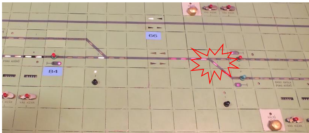
8. ábra: a biztosítóberendezés kezelőpultja (Erdei iskola 2. váltó szárcsíkja villog)
