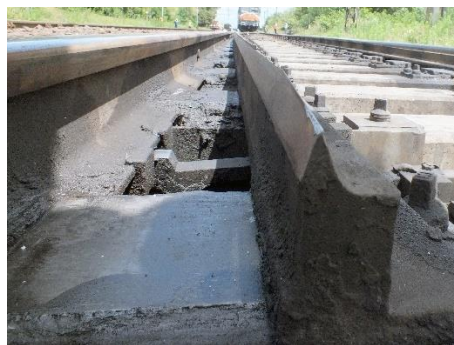
10. ábra: Ütési nyom a csúcssín hegyén
