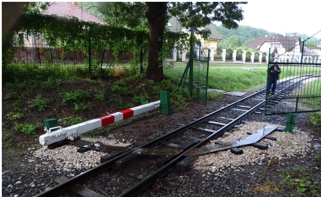
10. ábra: a vágányzáró sorompó az eset reggelén, és a megfutamodott kocsik által áttört kapu (a kapuszárnyak a kép készítésekor nem a kocsik menetirányának megfelelően álltak)
