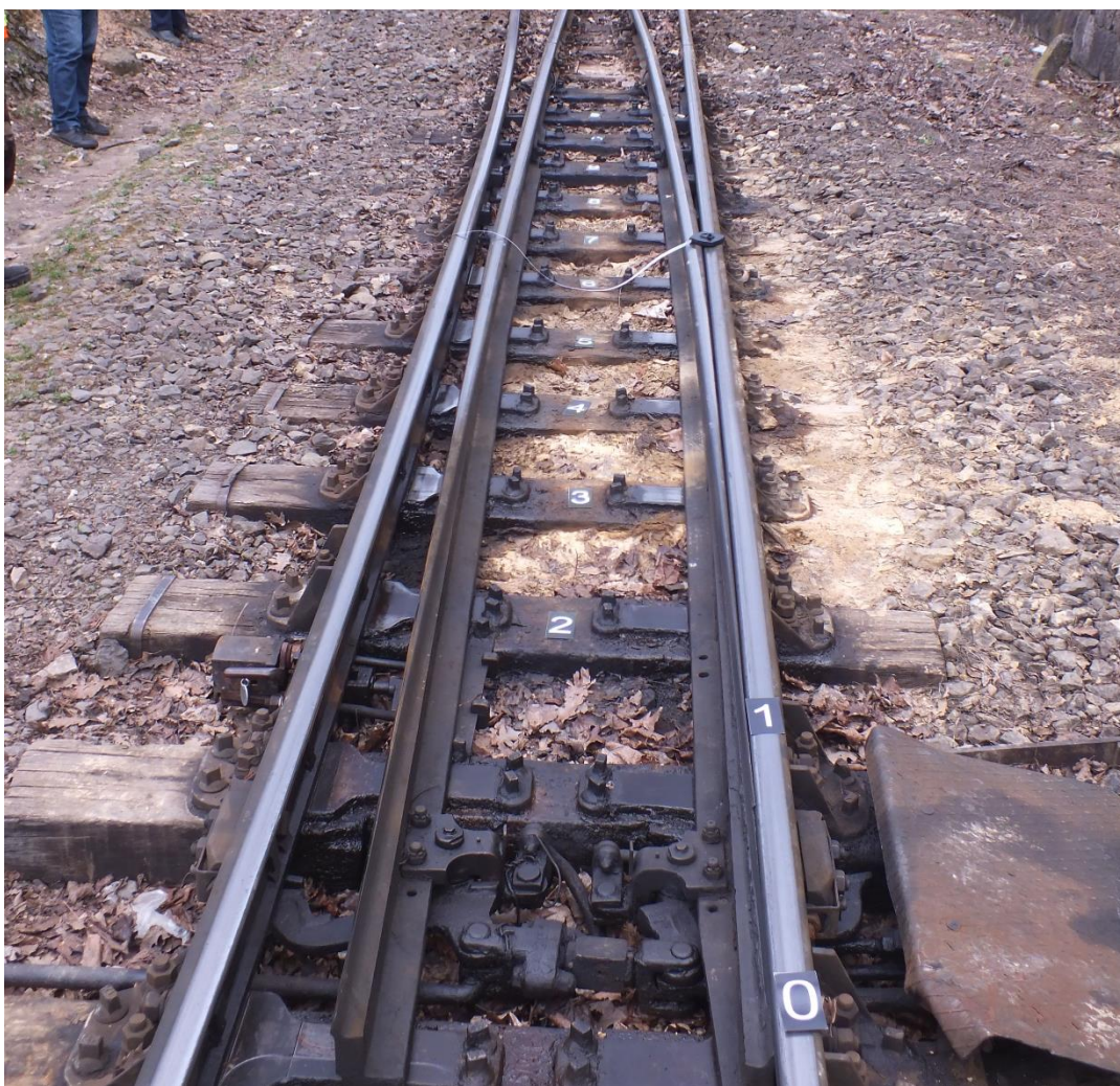
4. ábra: a kisiklás helyét jelentő váltó
