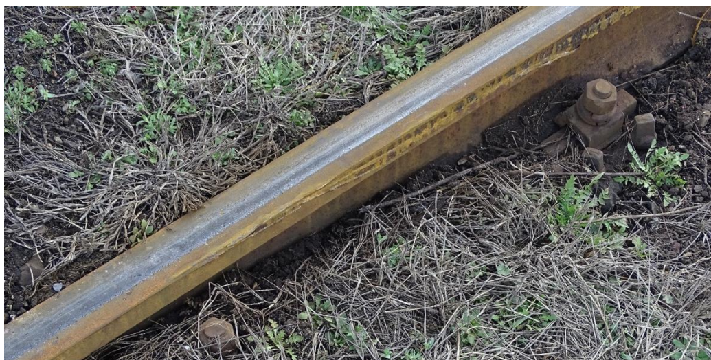
8. ábra A közézésés helyén a síncsavarok alig látszanak ki a földből
