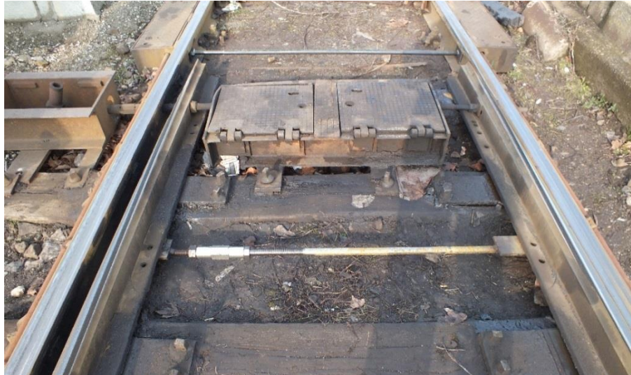
13. ábra: nyomtávartató és huzató
