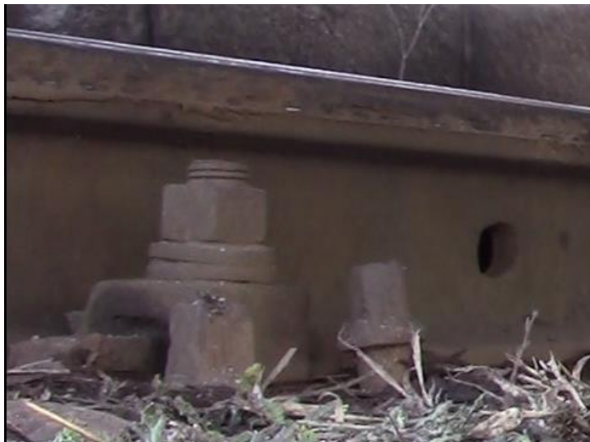
5. ábra: alátételemezt leszorító csavar
