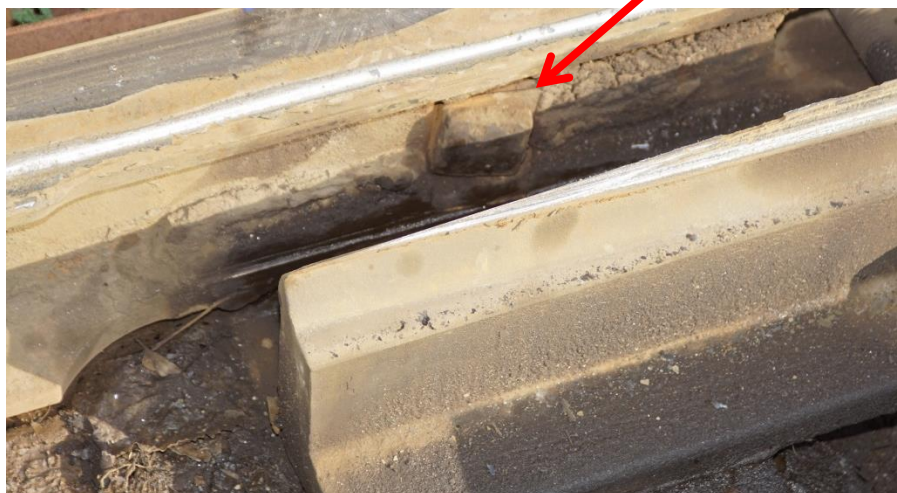
4. ábra: a tősin rögzítő csavarfej
