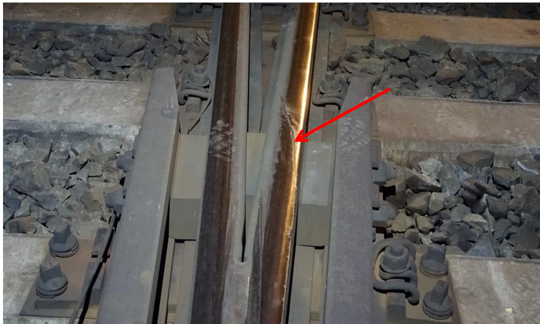
4. ábra: kisiklás- és lábnyom
