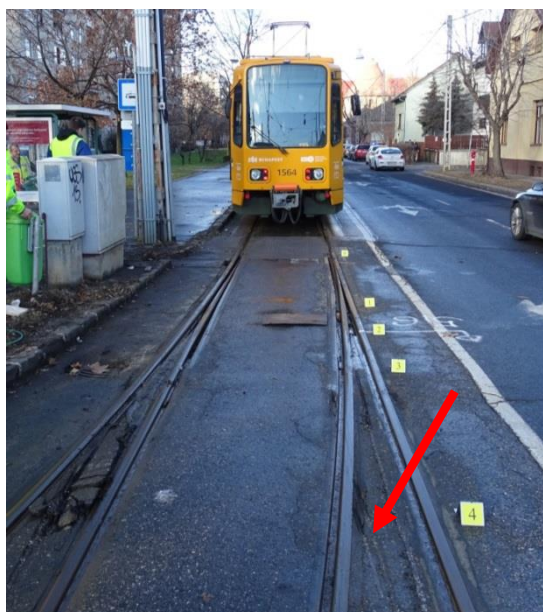
8. ábra: kerekek nyomai az aszfaltburkolaton
