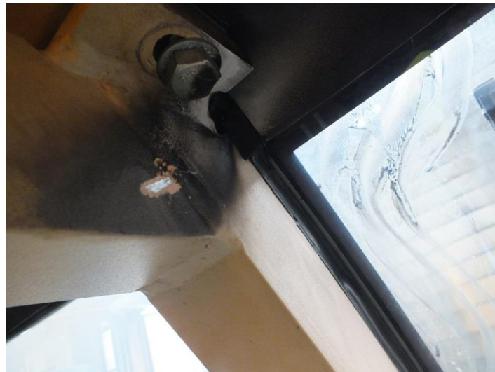
5. ábra: a villamos ív nyomai az alumínium oszlopon
