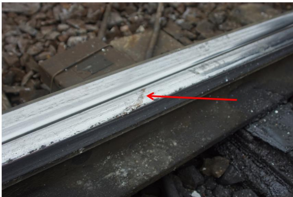
7. ábra: nyomkarima felkapási nyoma a külső oldalon (Ferencváros)
