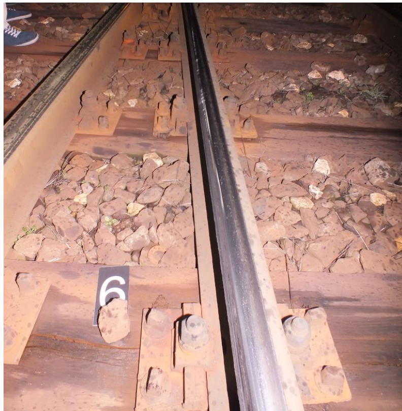
5. ábra: felkapási nyom és a nyomkarima sínkoronán futása (Kelebia)
