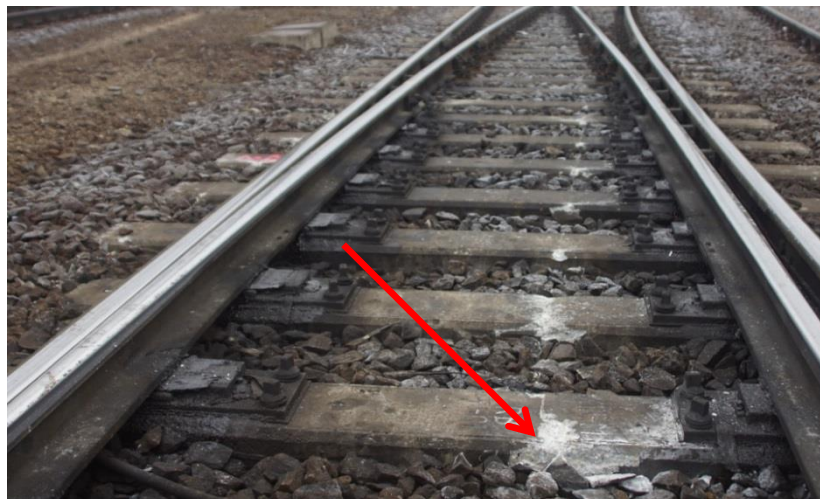
8. ábra: kerék lesési helye a belső oldalon (Ferencváros)
