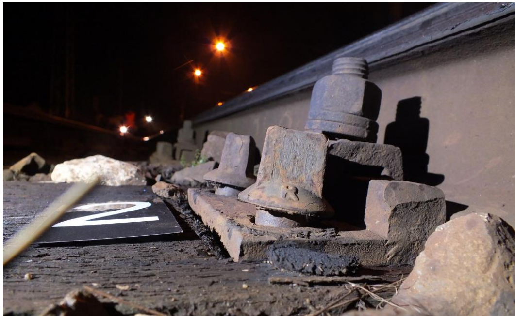
3. ábra: megdőlt csavarok a 27. aljon (Kelebia)
