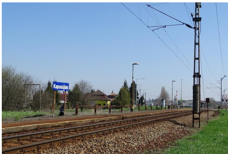
3. ábra Kaposújlak megállóhely
