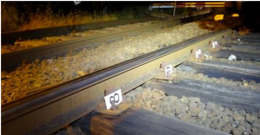
4. ábra: Hullámos mászásnyom a 8-B aljak között
