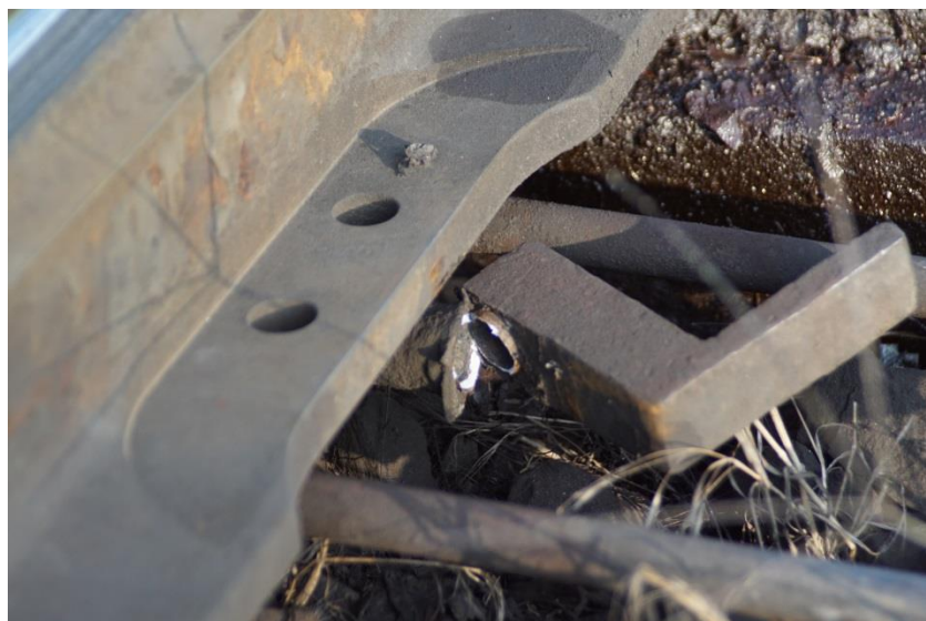
6. sz. ábra: A 447. sz. váltó váltózárának rongálódása
