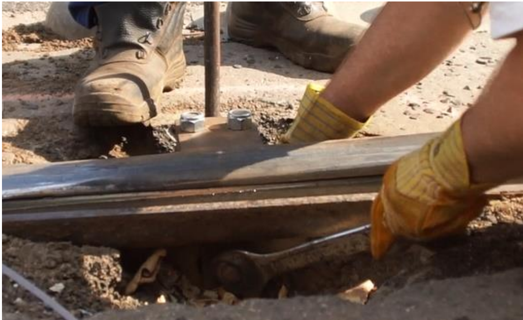
23. ábra: a csavar meghúzása, háttérben a rögzítőfület megtámasztásával
