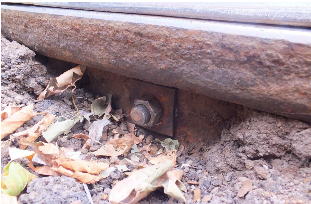
24. ábra: a csavar a meghúzás után
