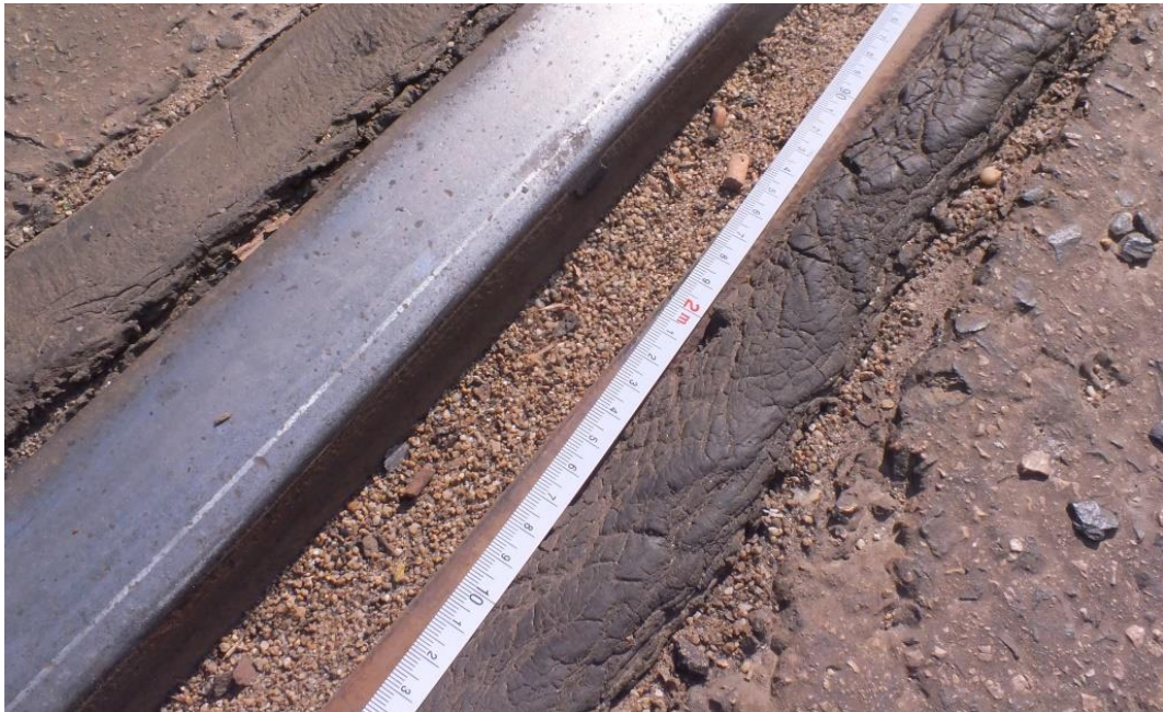
10. ábra: folyamatos csík a jobb sínszálon
