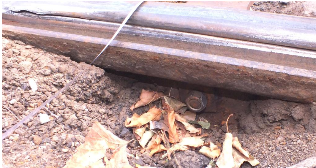
7. ábra: a rámpát oldalirányban rögzítő csavar
