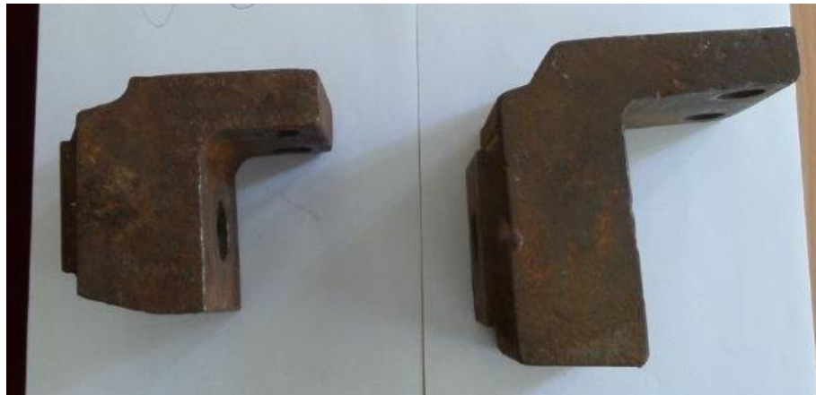
17. ábra: a vignole (balra) és a főnix sínhez (jobbra) alkalmazott rögzítőtuskók (fotó: BKV Zrt.)
