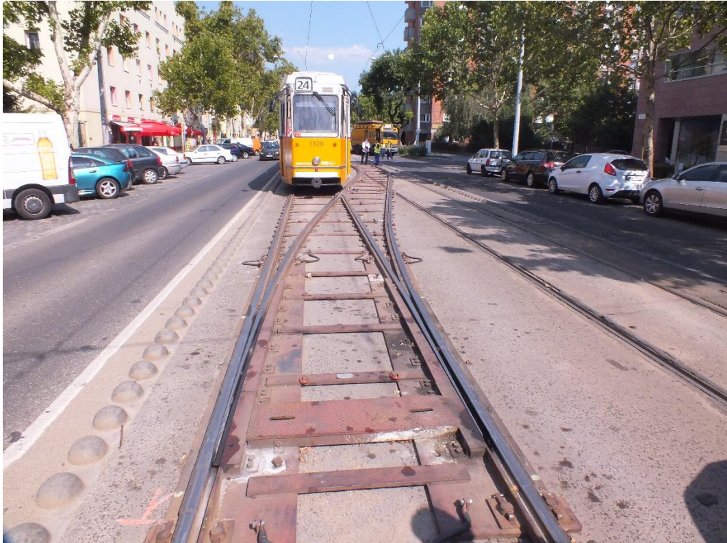
13. ábra: az ideiglenes vágánykapcsolat látképe (a képen az eset idején ellenirányból érkező villamos látható)
