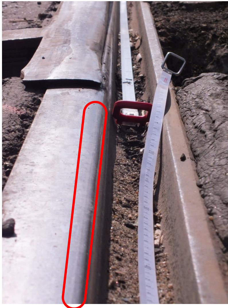
11. ábra: a sín futófelületén lévő csík és a rámpa élének egybeesése
