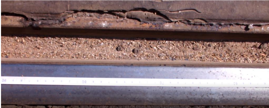
9. ábra: terhelési nyomok a bal sínszál sín orrán (a mérőszalag 2 m-es beosztása van a nullponton)
