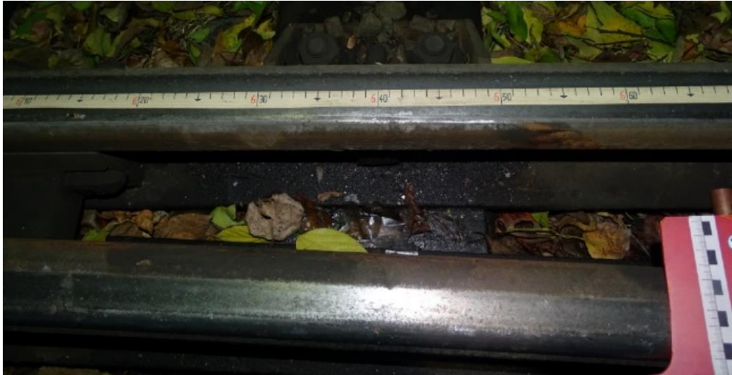
8. ábra: nyomok a bal tősinen októberben (a mérőszalag 1 m-es osztása van a csúcssín hegyénél)
