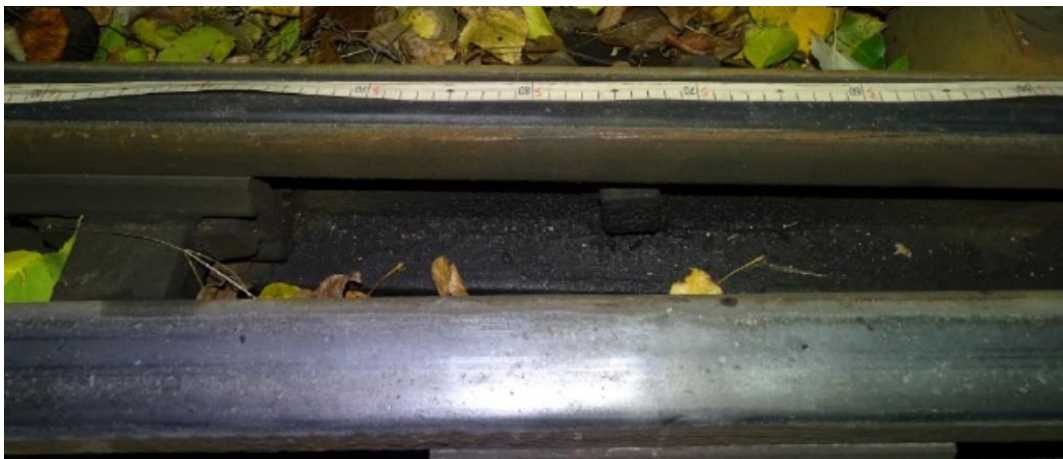
6. ábra: nyomok a jobb tősinen októberben (a mérőszalag 1 m-es osztása van a csúcssín elejénél)
